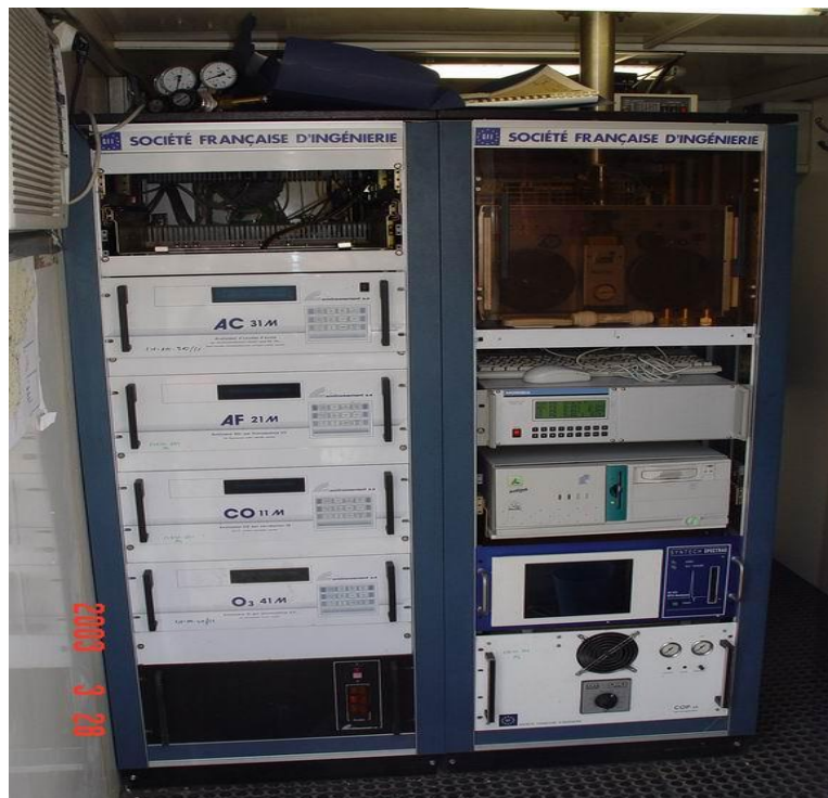
Tipikus automata mérőállomás belseje
